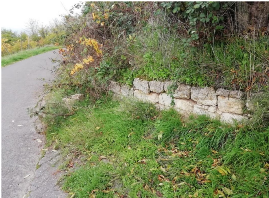
Überwachsene Trockenmauer mit Lösslehmwand (N Wackernheim, 11/2022)
